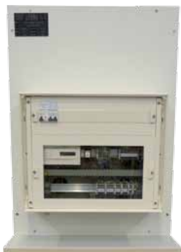
Face arrière du panneau avec son coffret de raccordement.
