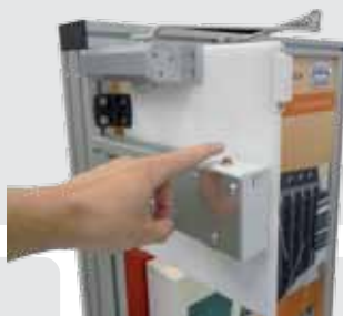
Porte coupe feu avec ventouse électromagnétique et contact sec
